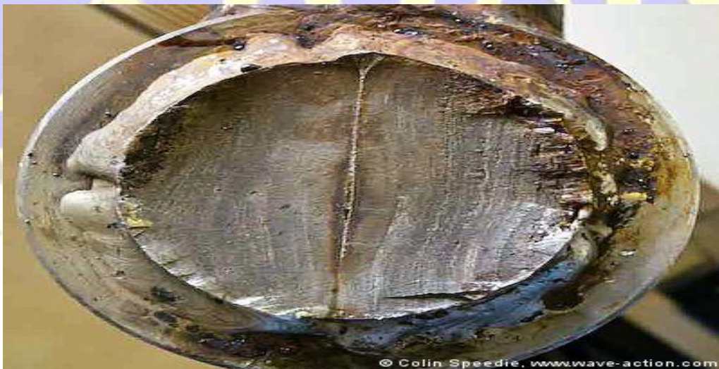
Gambar 5.7 Korosi Lelah ( Fatigue Corrosion )
